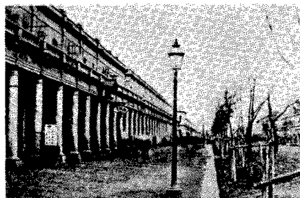
写真1 銀座大通り(明治6年煉瓦街竣工直後) 〔藤森, 1982; 図12より〕
