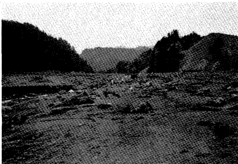
写真12 濁川・王滝川合流点付近の堆積状況 (その1)
