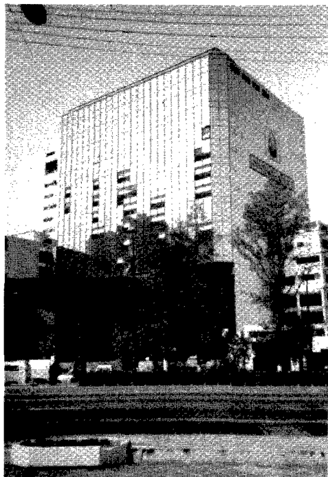
写真2. No.26 約4年前築のRC造15階建ての政府 関係の事務所(大)
