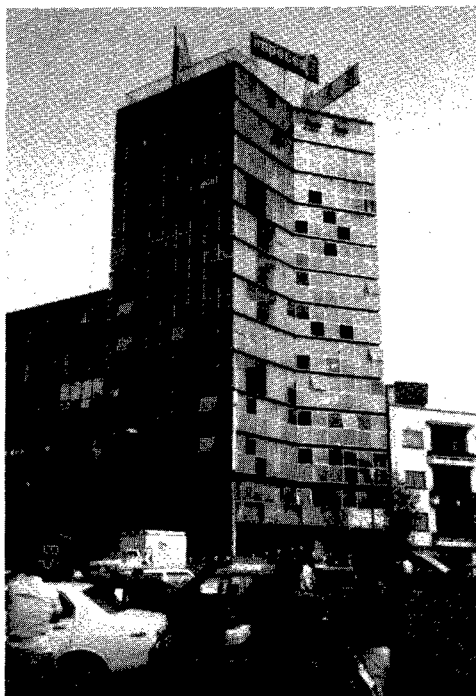
写真8. No.96 約15年前築のRC造13階建ての 政府建物(大)
