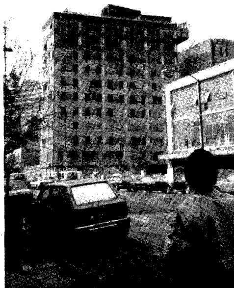
写真3. No.32 約25年前築のRC造11階建ての 事務所(大)
