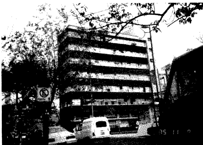
写真9. No.97 約15年前築のRC造8階建ての 事務所(大)
