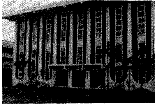
写真-29 2階建講堂，体育館
