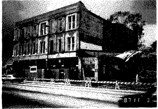
写真-11 パラペット、外壁の一部が落下した 組積造建物 (パサディナ市) *隣接する自動車修理店を押しつぶした。
