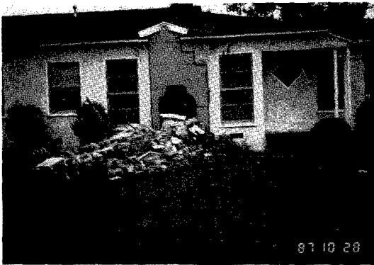
写真-2 崩壊した住宅の煙突部分 (ウイットティア市)
