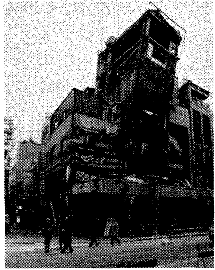
写真12 鉄骨ラーメン構造の過大変形による大破
