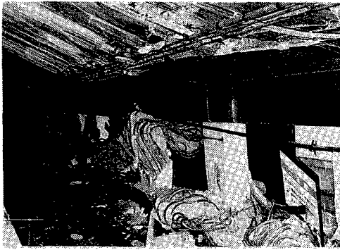
写真1 神戸高速鉄道大開駅地下2階の中柱の被害(a) 1), 9)
